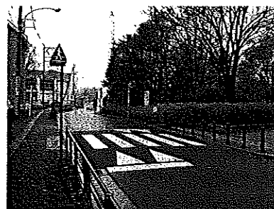
写真1 ハンプすりつけ部に路面標示
